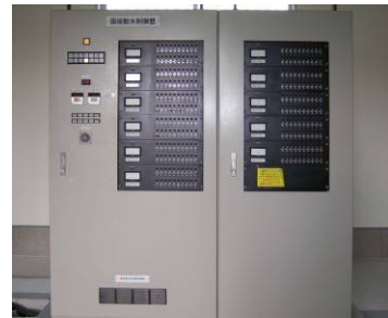
各散水管理所に設置された散水制御盤
