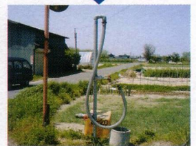
共同給水栓／消火栓
