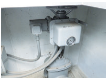
天神川から送られてきた水を貯水槽に送るための分水弁です。
