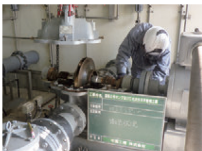
ポンプケーシングの上蓋を持ち上げ中の状況を確認しています。
