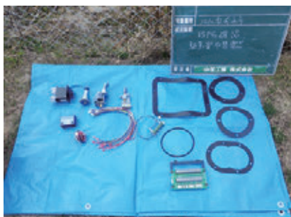
分水弁の駆動部が故障しているため新しい部品と交換します。
