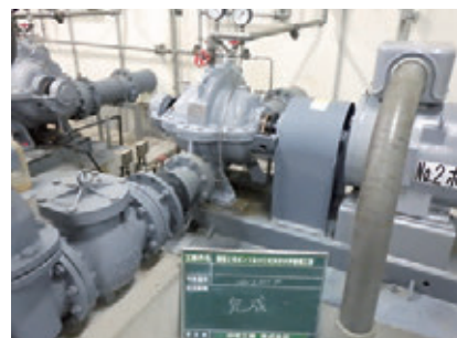
整備が完了しました。これで安心して送水できます。
