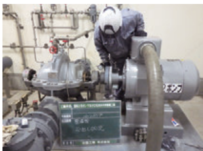
モーターとポンプとの回転軸を合わせするための芯出し作業です。
