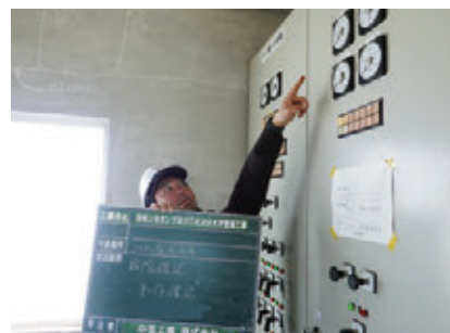
完成後の動作確認では問題なく開閉できることを確認しました。
