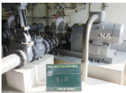
国坂2号ポンプの整備前です。
