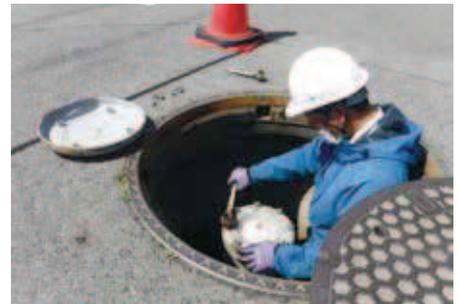
幹線水路の空気弁を点検しています。空気弁にゴミが詰まると水漏れの原因になります。冬季には37か所ある幹線水路の空気弁をすべて分解点検しています。
