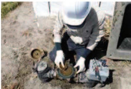
自動散水を行う電磁弁は、内部の泥汚れが原因で止まらなくなることがあります。約1,200個の電磁弁を計画的に3年間で全数分解点検しています。
