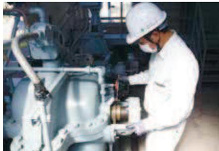
揚水ポンプの調整をしています。日常点検でのわずかな異常も見逃さず、原因を究明し速やかに対処します。経験がないとできない仕事です。
