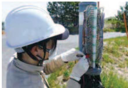
電磁弁を制御するケーブルが落雷等で断線することがあります。故障区間を特定し予備ケーブルに繋ぎ直します。
