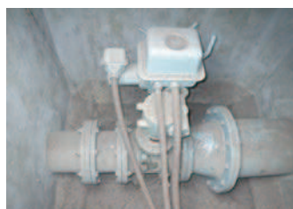
【整備前の分水弁】
