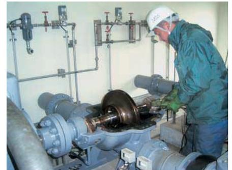
冬季には全てのポンプを分解点検し、内部の異常が無いかを確認し、錆や汚れを取り除いてから消耗品を交換して組み立てます。機器の寿命を延ばすためには不可欠な仕事です。
