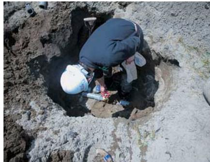
普段の修理で多いのがバルブ交換です。組合費の上昇を抑えるため、可能な限り修理で対応し、やむを得ない場合は交換します。
