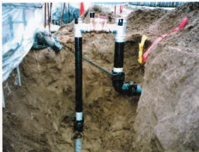
電磁弁設置
