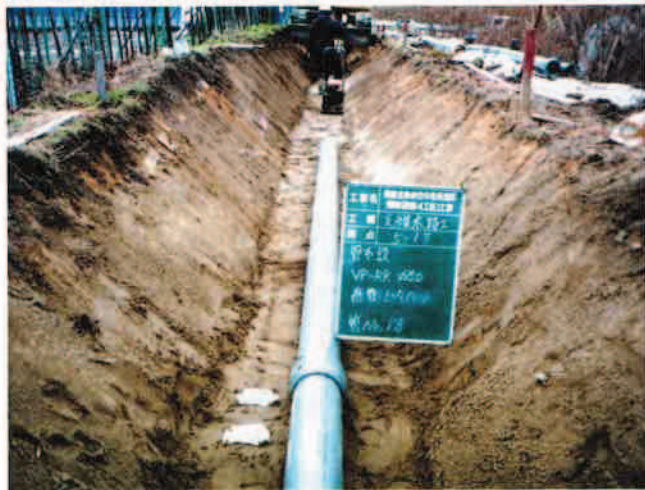
支線水路布設（道路下）
