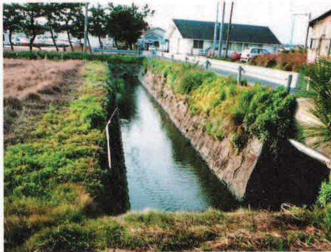
排水路改修前
